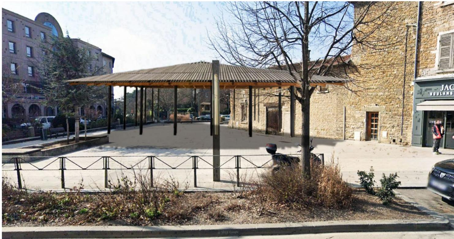
Proposition n° 1, inspirée de la halle de Marcy l'Etoile. Toiture à ossature bois sur piliers métalliques En période caniculaire la température est de 3 à 5°C inférieure sous la halle par rapport à l'extérieur
